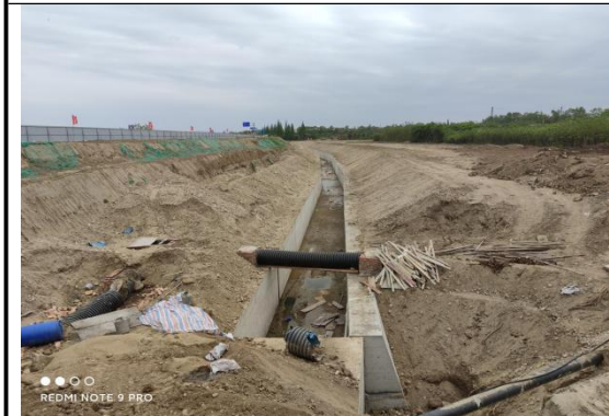
明渠施工现状
