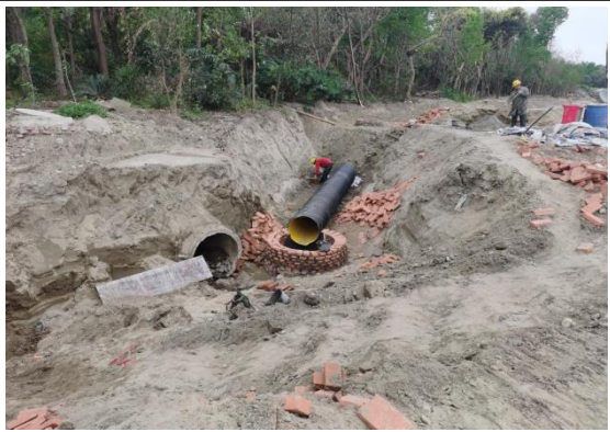
管道施工现状
