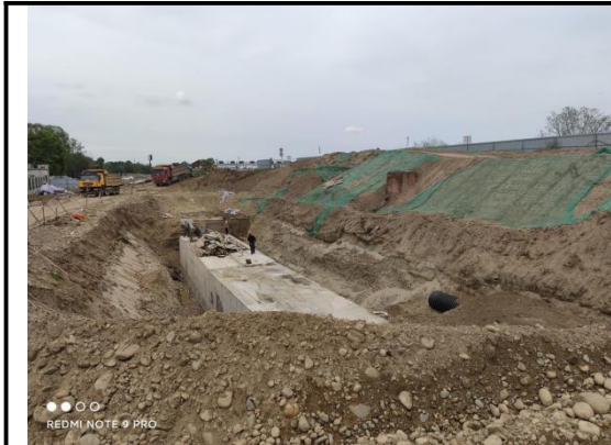
暗渠施工现状
