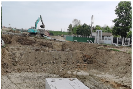
明渠施工现状
