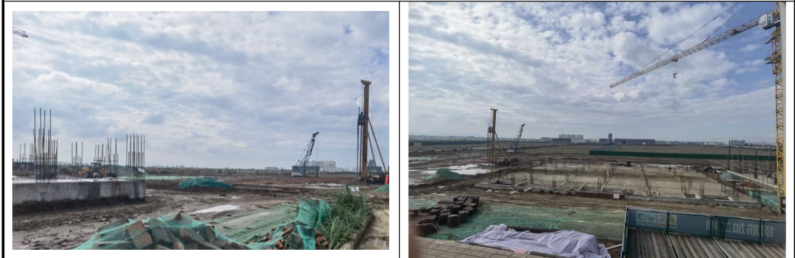
在建的一期建构筑
