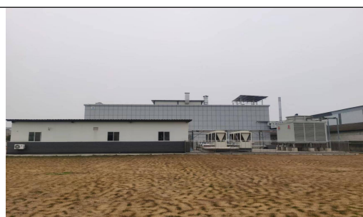
项目北侧（公共系统间）
